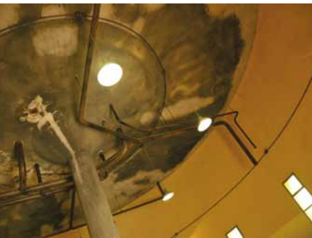
5. Serbelli, strop ciepłowni – wejście i informacja
